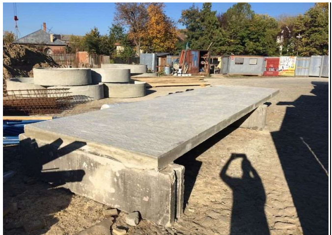
Рис.6. Готова плита після розпалублення Fig.6. Ready slab after uncoupling
