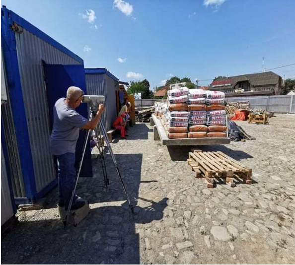
Рис.11. Вимірювання переміщень під час навантаження плити
